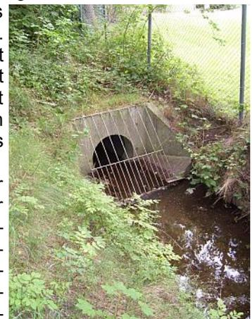
Abb. 3: Einmündung in die Kanalisation
