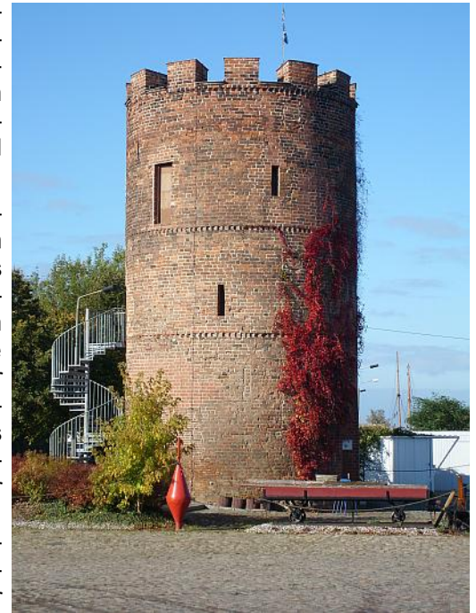
Abb. 5: Der restaurierte Fangenturm
